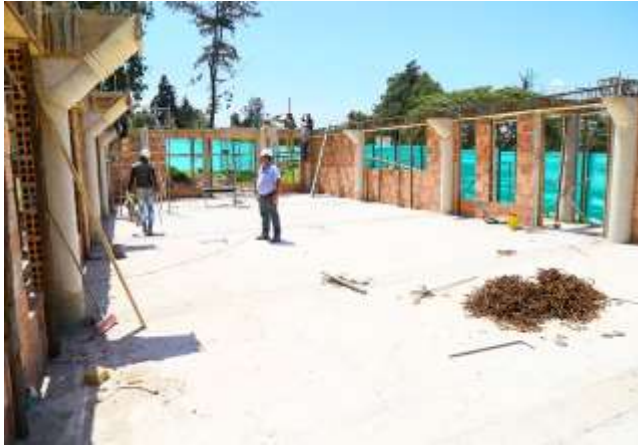
Construcción comedor IETAAN
